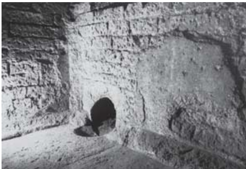
Abb. 75: Absetzbecken im Grüngürtel vor Köln. Bei Öffnung der Spülschleuse wurde der auf der Beckensohle abgelagerte Schlamm durch den Druck des Wassers selbsttätig hinausgespült.
