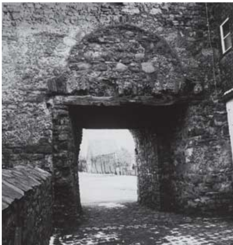
Abb. 60: Wiederverwendung römischen Gussbetons aus der Eifelwasserleitung im Torturm der Rheinbacher Burg (12. Jahrhundert).
