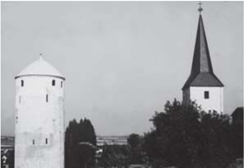
Abb. 68: Im Hexenturm (12. Jahrhundert) und in St. Walburgis von Bornheim-Walberberg ist reichlich Material aus dem Abbruch des Römerkanals wiederverwendet worden.
