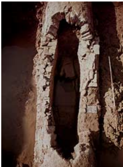
Abb. 17: Tosbecken bei Mechernich- Lessenich. Durch Ausbuch- ten der Leitungswangen ist der Querschnitt künstlich vergrößert worden.
