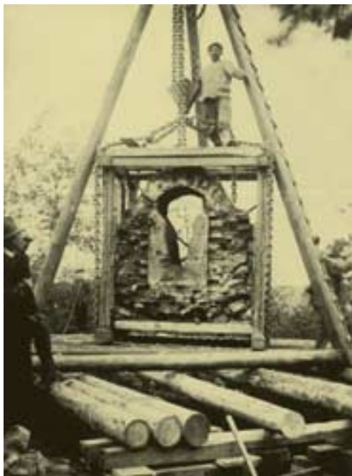
Abb. 20: Ausbau eines Teilstückes der Eifelwasserleitung in Euskirchen-Kreuzweingarten für die Kölner Werk- bundaussstellung im Jahre 1914.
