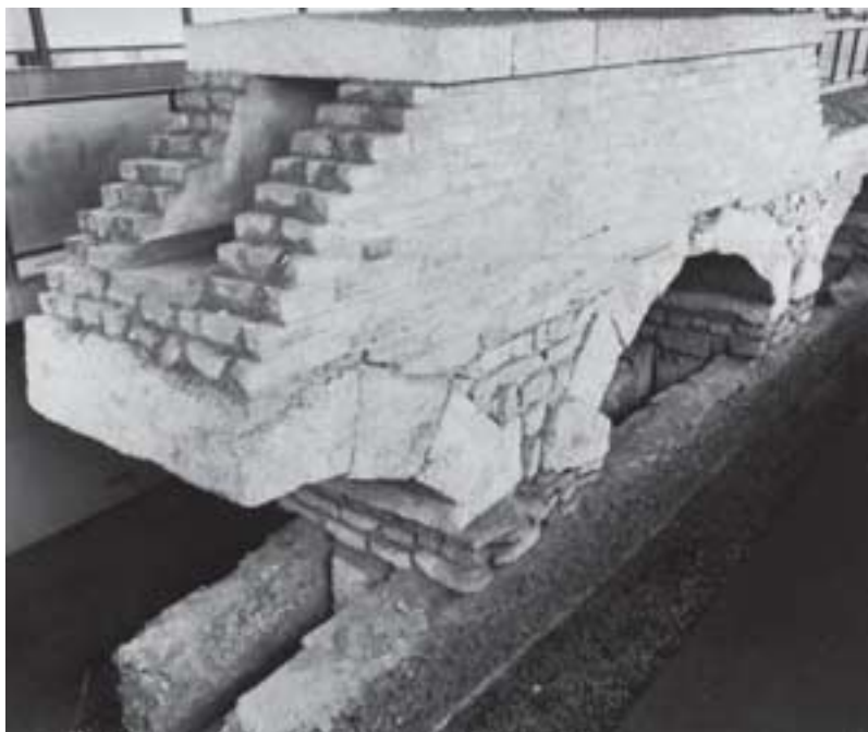
Abb. 72: Doppelleitung in Hürth-Hermülheim. Konservierter und ergänzter Ausgrabungsbefund hinter der Realschule.
