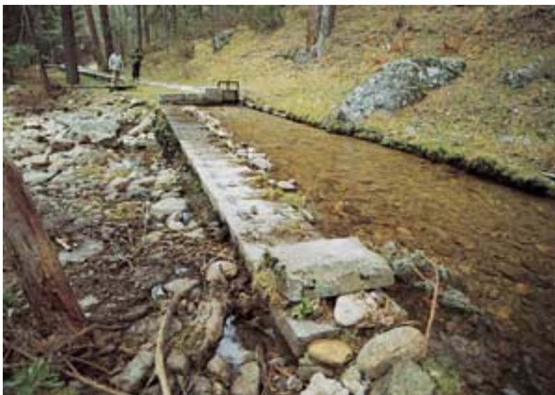
Abb. 79: Römische Flussableitung im Rio de la Acebeda für die Versorgung des antiken Segovia (Spanien).
