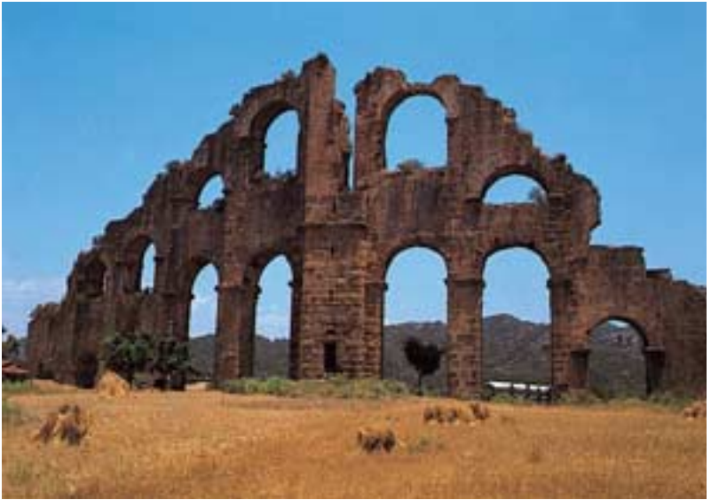
Abb. 99: Turm zur Druckentlastung im Zuge der Druckleitung von Aspendos (Türkei).
