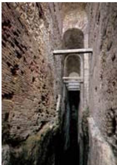
Abb. 95: Ausgemauerter Bau- und Belüftungsschacht des Claudius-Tunnels am Fuciner See.
