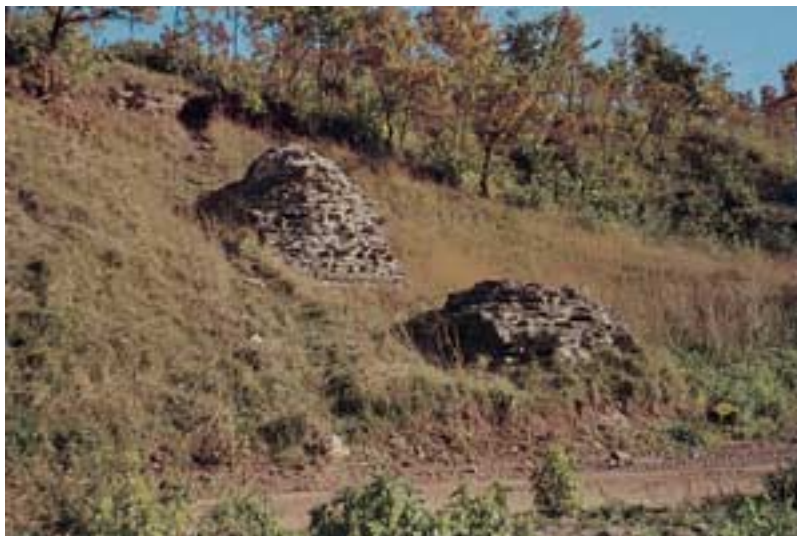
Abb. 10: Pfeilerstümpfe der Aquäduktbrücke Mechernich-Vussem im Ausgrabungsbefund vor der Rekonstruktion (1957).
