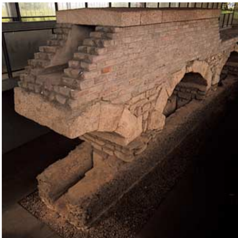
Abb. 27: Doppelstöckige Leitung in Hürth-Hermülheim hinter der Realschule. Der Befund oberhalb der Bögen ist 1962 rekonstruiert worden.
