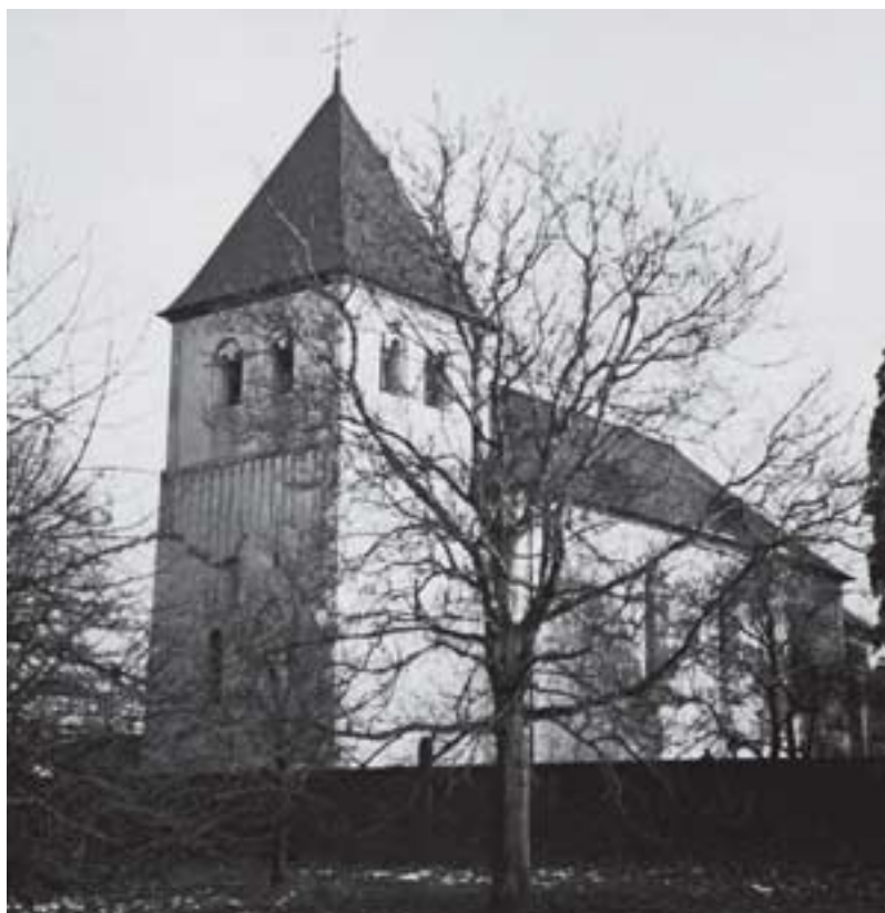
Abb. 64: In St. Peter in Meckenheim-Lüftelberg findet man eine Grabplatte aus Kalksinter der Eifelwasserleitung.
