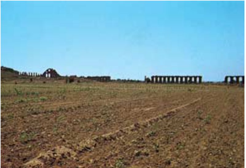
Abb. 100: Die Druckleitung durch die Talsenke vor Aspendos (Türkei) mit einem der zwei Entlastungstürme.
