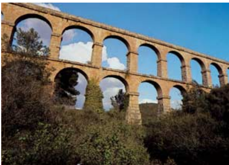
Abb. 91: Zweigeschossige Aquäduktbrücke aus dem Verlauf der Wasserleitung nach Tarragona (Spanien).
