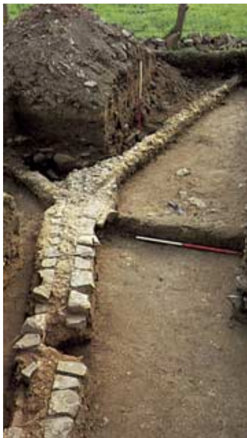
Abb. 78: Wasserfassung durch Ummauerung eines Quellgebietes bei Euskirchen-Kirchheim.
