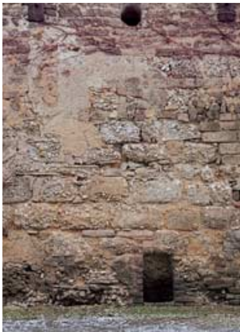
Abb. 31: Im ehemaligen Kloster Schillings-Kapellen bei Swisttal-Dünstekoven ist im 12. Jahrhundert reichlich Kanalabbruch zum Bauen verwendet worden.
