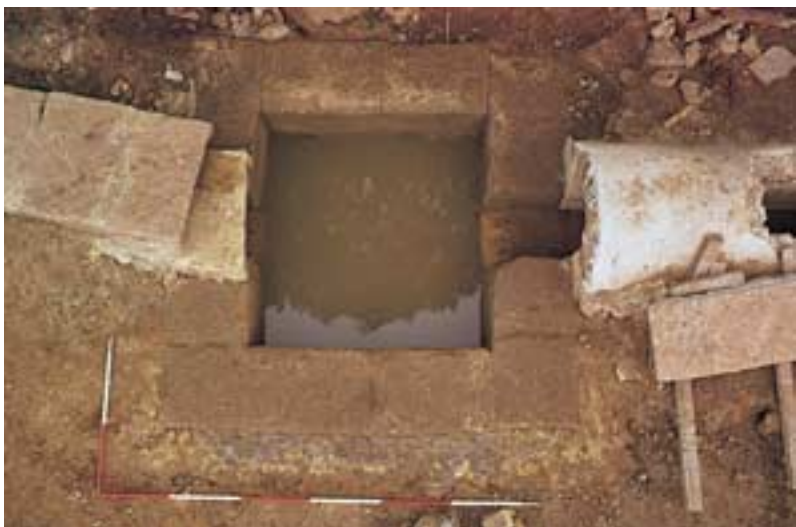
Abb. 2: Wasserfassung Grüner Pütz bei Nettersheim. Blick auf das offenliegende Fundament; links der Anschluss der Sickerleitung, rechts die Wasserleitung nach Köln.
