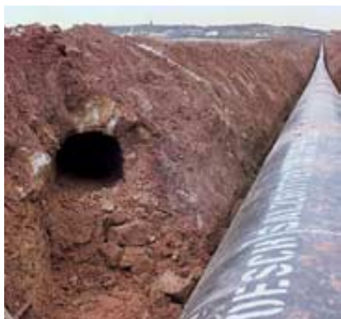
Abb. 5: Zwei Generationen von Fernleitungen begegnen sich: Bei Kall-Scheven durchschneidet die Trasse einer Ferngasleitung die Eifelwasserleitung.
