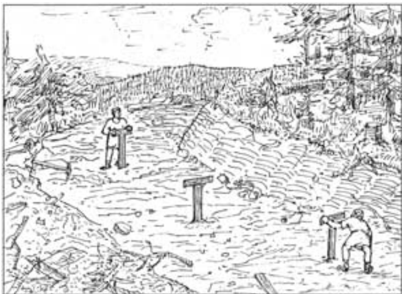
Abb. 112: Feinabsteckung der Höhen bei der Trassierung einer römischen Wasserleitung. Auf der vorbereiteten Arbeitsterrasse wird das Sollgefälle der Sohle durch Austafeln abgesteckt.
