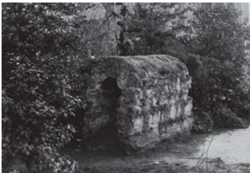
Abb. 70: Wiederaufgebautes Teilstück der ältesten Vorgebirgsleitung in Hürth, Brabanter Platz.
