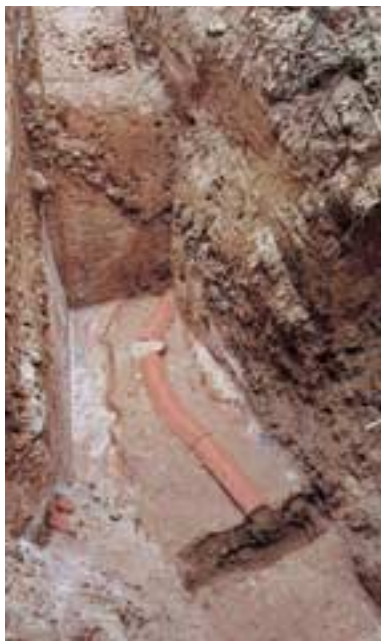
Abb. 97: Drover-Berg-Tunnel bei Düren. Die mit halbrunden Dachziegeln abgedeckte Wasserleitung knickt aus dem Hangverlauf in den Tunnel ein.
