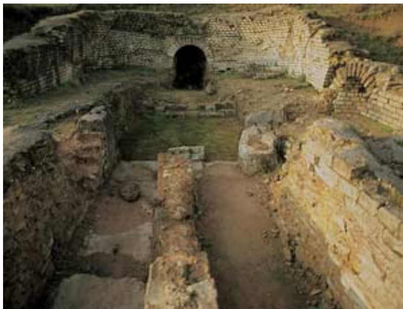
Abb. 103: Absetzbecken und Nymphäum vor der Aquäduktbrücke über die Mosel im Zuge der Wasserleitung nach Metz (Frankreich).
