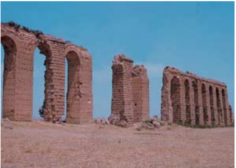
Abb. 89: In nachrömischer Zeit wurden die Pfeiler der Wasserleitung nach Karthago ihrer Bruchsteinschale beraubt und statt dessen mit Stampflehm ummantelt.
