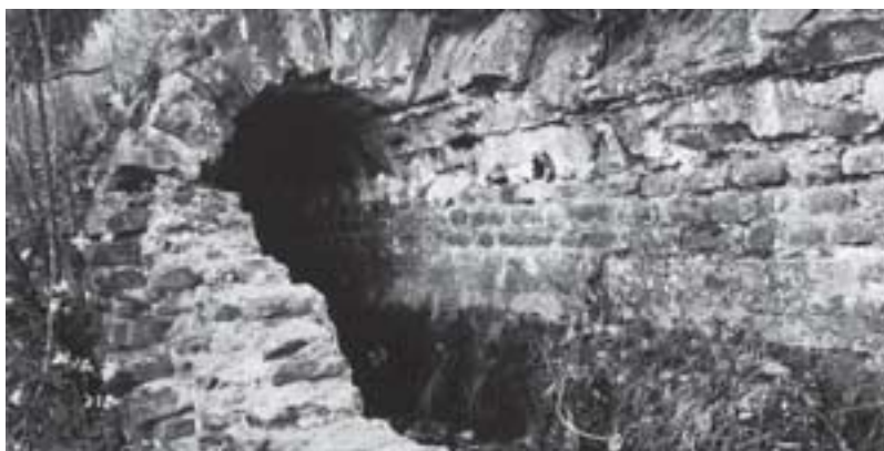
Abb. 48: Der Leitungsaufschluss bei Mechernich-Breitenbenden zeigt im Gewölbe die Abdrücke der Schalbretter des Lehrgerüsts und an den Wangen einen Fugenstrich.
