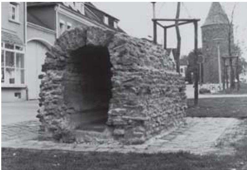
Abb. 59: Wiederaufgebautes Teilstück der Eifelwasserleitung in Rheinbach.
