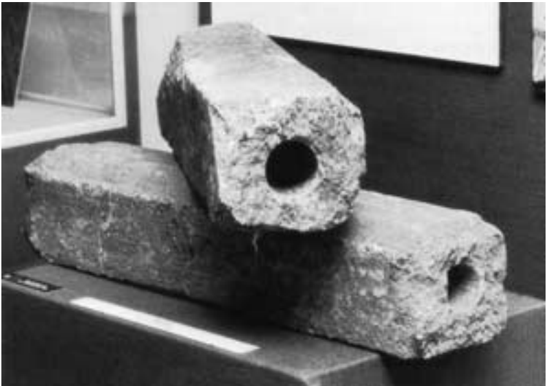
Abb. 84: Fertigrohr einer römischen Wasserleitung aus Gussbeton im Museum von Metz (Frankreich).
