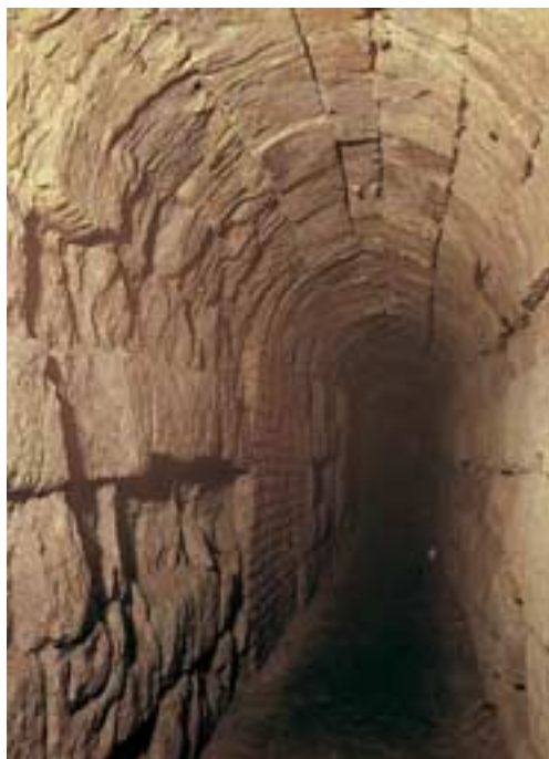
Abb. 30: Römischer Abwasserkanal unter der Budengasse in Köln, heute vom Prätorium aus zugänglich gemacht.
