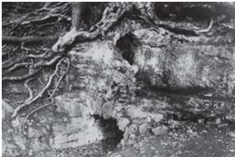
Abb. 41: Wasserleitung mit Durchlass für die Oberflächenwasser eines Siefens oberhalb von Burg Dalbenden bei Kall-Urft.
