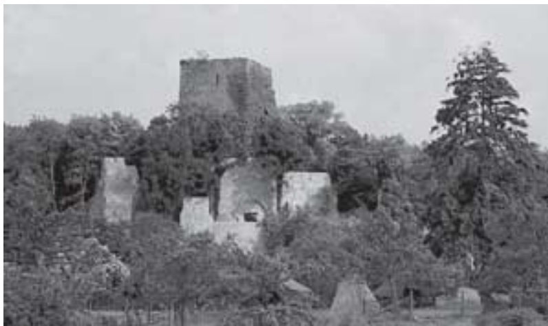
Abb. 55: In der Hardtburg bei Euskirchen-Stotzheim ist in geringen Maßen Abbruch aus dem Römerkanal verbaut worden.
