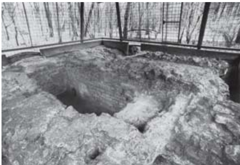
Abb. 74: Absetzbecken im Grüngürtel vor Köln. In der hinteren Ecke unten die Spülschleuse für den abgelagerten Schlamm.
