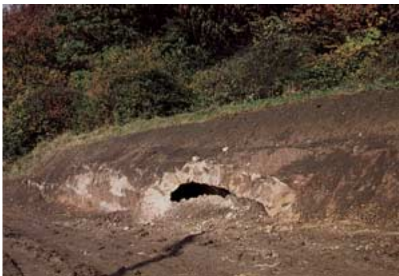
Abb. 4: Die teilweise zerstörte Wasserleitungsrinne bei Kall-Urft. Bei der Anlage eines Weges wurde 1959 die Eifelwasserleitung freigelegt, sie ist hier heute noch zugänglich.
