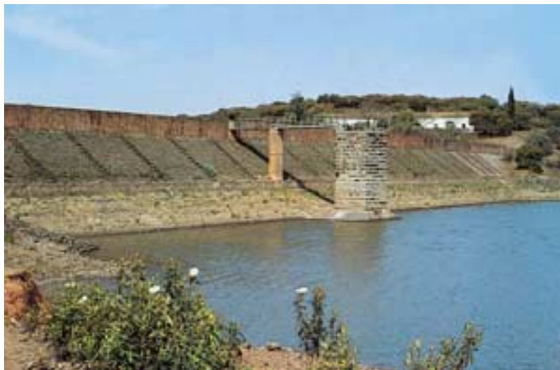
Abb. 81: Cornalvo-Staumauer mit vorgelagertem Entnahmeturm bei Mérida (Spanien).
