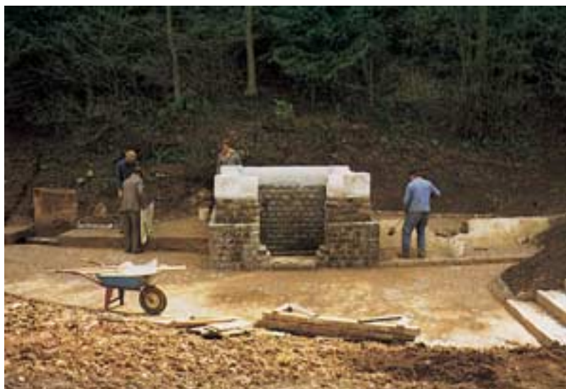
Abb. 3: Die Wasserfassung Grüner Pütz bei Nettersheim während der Rekonstruktionsarbeiten an den Aufbauten.
