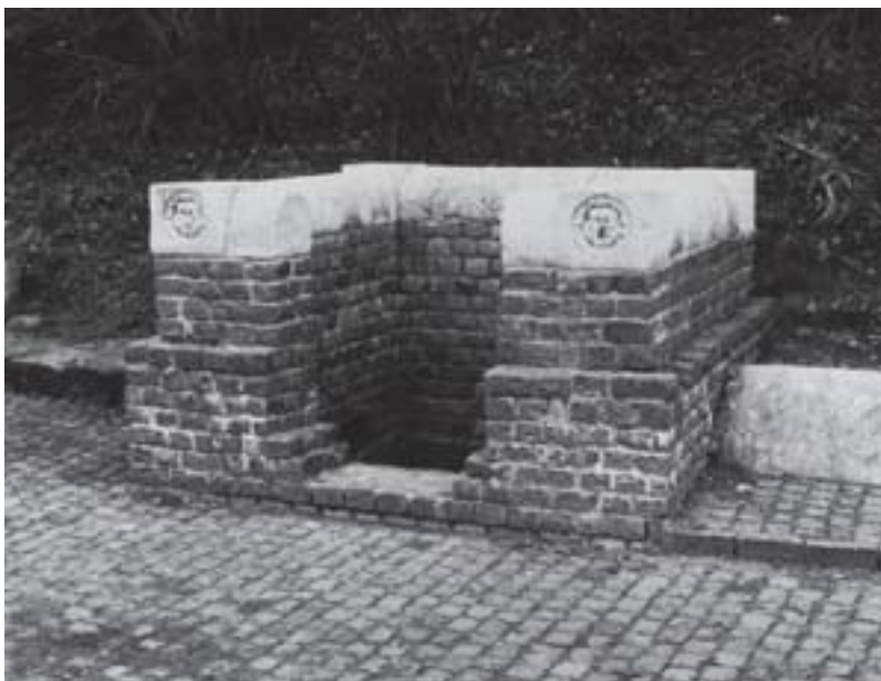
Abb. 38: Rekonstruierte Wasserversorgung Grüner Pütz bei Nettersheim.
