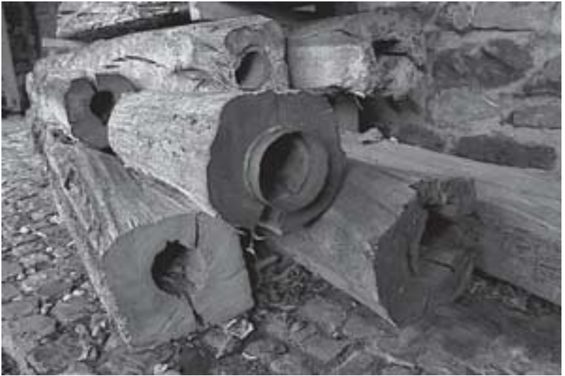
Abb. 83: Holzrohre einer römischen Wasserleitung aus Aachen; selbst die eisernen Deichelringe sind gut erhalten.
