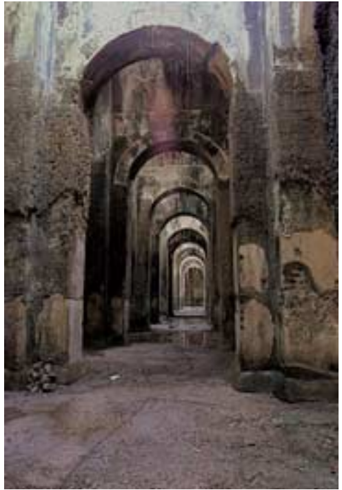
Abb. 104: Piscina Mirabilis, am Kap Misenum im Golf von Neapel gelegener Wasserspeicher.
