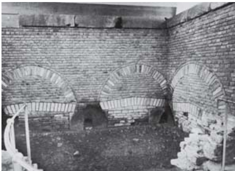
Abb. 43: Brunnenstube Klausbrunnen bei Mechernich-Kallmuth im Zustand nach der Wiederherstellung von 1953.
