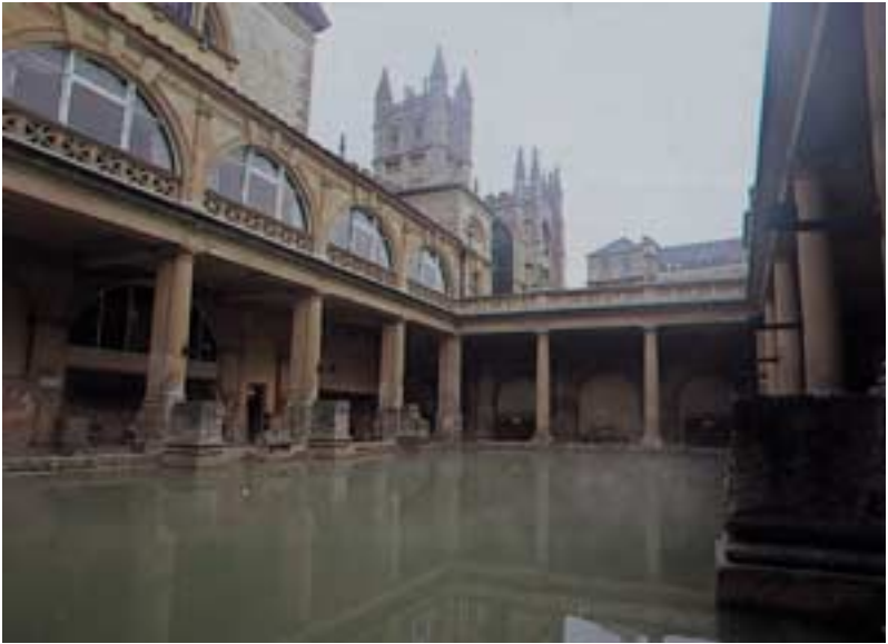
Abb. 107: In den Thermen von Bath (England) sind zahlreiche römische Bauteile erhalten, darunter das Becken des großen Bades.
