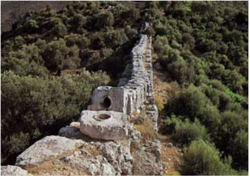
Abb. 101: Steinerne Druckleitung durch einen Geländesattel in den Bergen oberhalb von Patara (Türkei).
