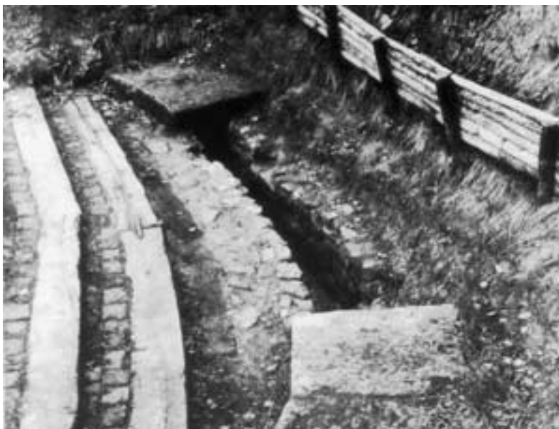
Abb. 37: Sickerleitung zur Sammlung des aus dem Hang tretenden Quellwassers am Grünen Pütz bei Nettersheim.
