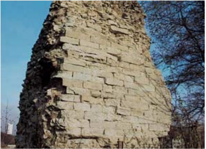
Abb. 88: An wenigen Pfeilern der Aquäduktbrücke über das Mainzer Zahlbachtal ist die Verkleidung aus glatt behauenen Bruchsteinen noch gut erhalten.
