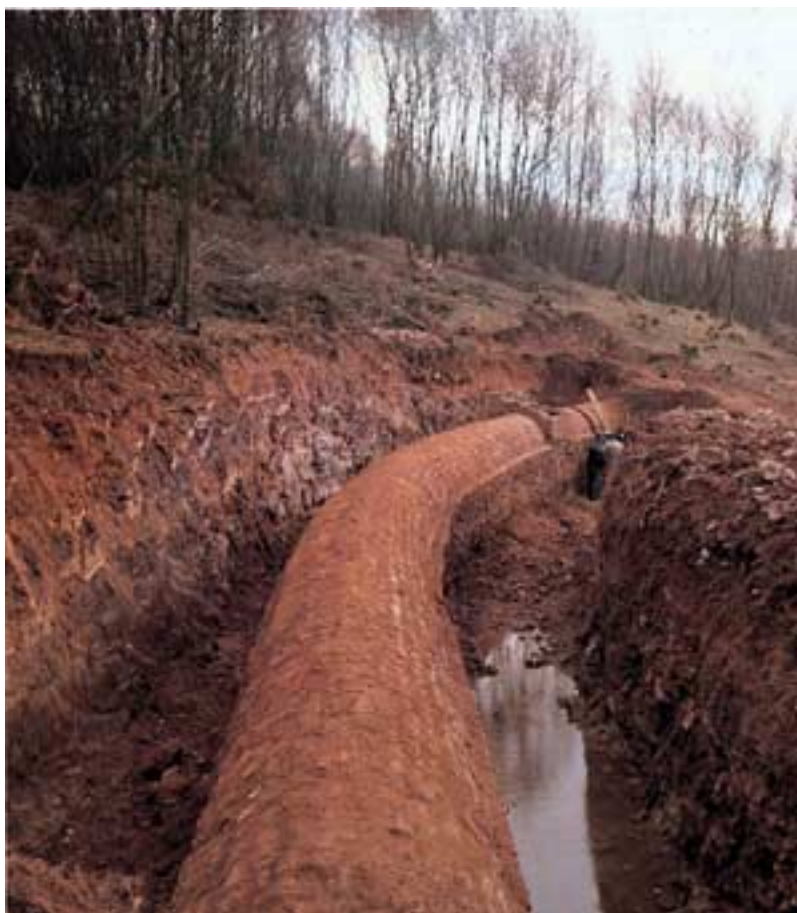
Abb. 12: Freilegung eines längeren Teilstückes der Eifelwasserleitung bei Mechernich-Breitenbenden. Der Kanal musste hier einem Brückenbauwerk weichen; er wurde stückweise ausgebaut und an anderen Orten wiederaufgestellt.
